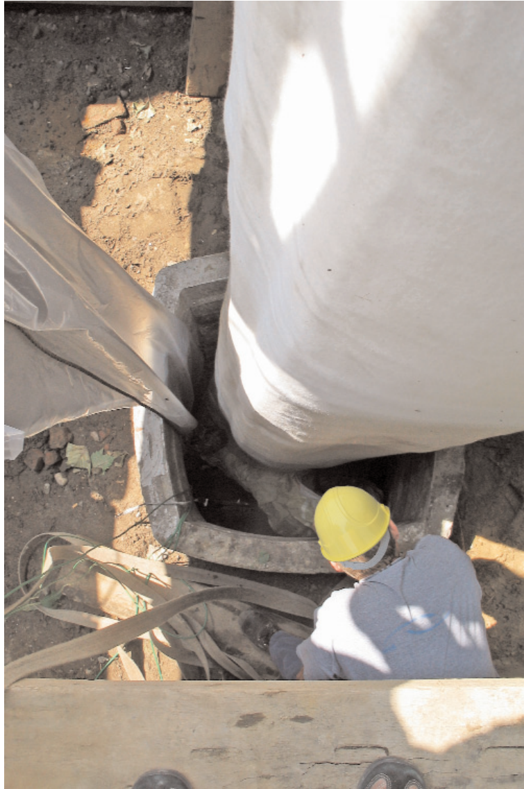
Einführen des Schlauchliners in das zu sanierende Eiprofil.
