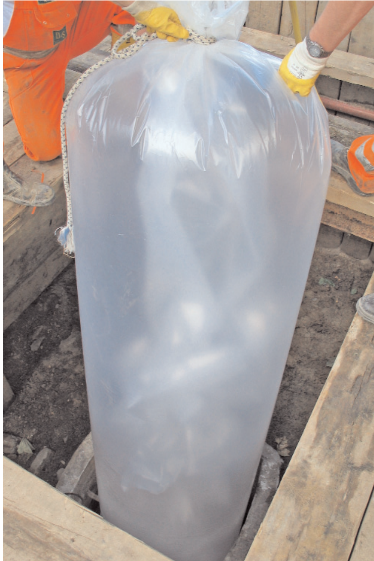
Einbau des Preliners.
