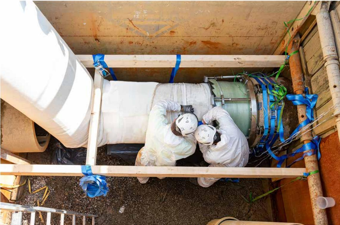
... und durch den CODURE-Flansch hindurch in die Leitung invertiert.
