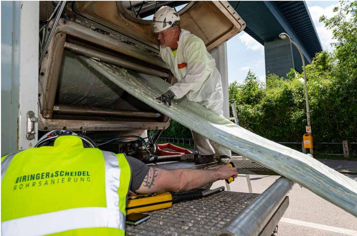
Der Schlauchliner wird in die Inversionstrommel gewickelt.
