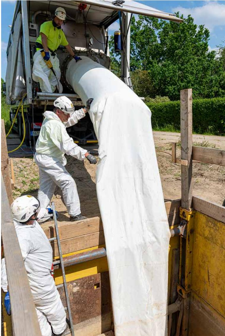
Aus der Inversionstrommel heraus wird der BlueLiner in die Startgrube geführt...
