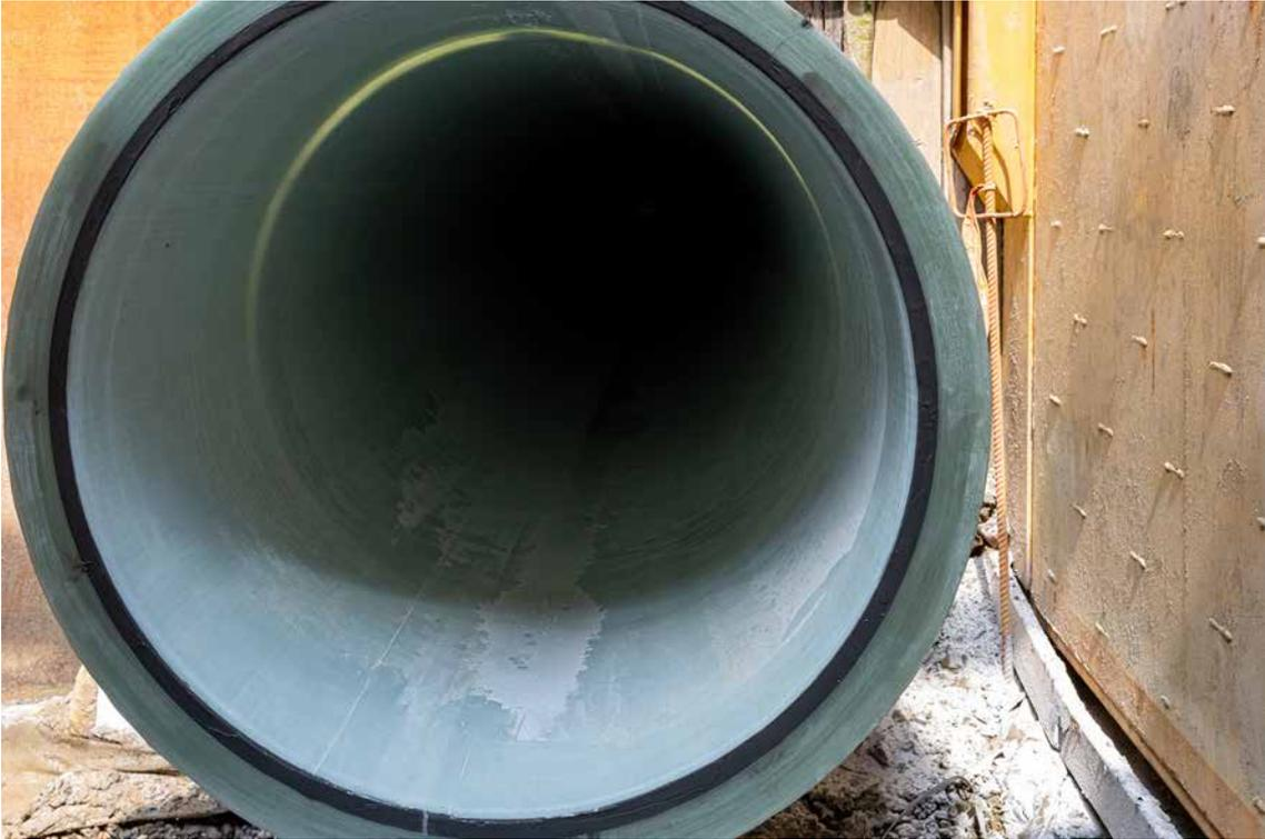
Eine saubere Sache: Nach fachgerechter Installation können Liner und CODURE-Flansch mit dem entsprechenden Gegenstück wieder mit der Altrohrleitung wieder verbunden werden.
