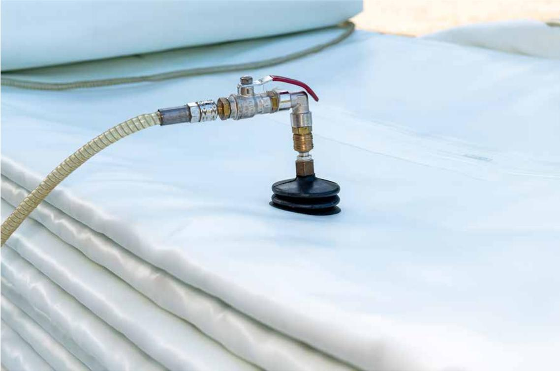
Die Imprägnierung des Schlauchliners erfolgt unter Vakuum.
