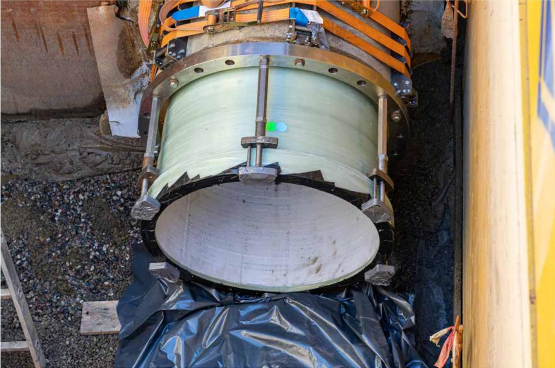
Durch die Verklebung des hier vorbereiteten CODURE-Flansches mit dem Liner während der Härtung entsteht ein System „aus einem Guss“.
