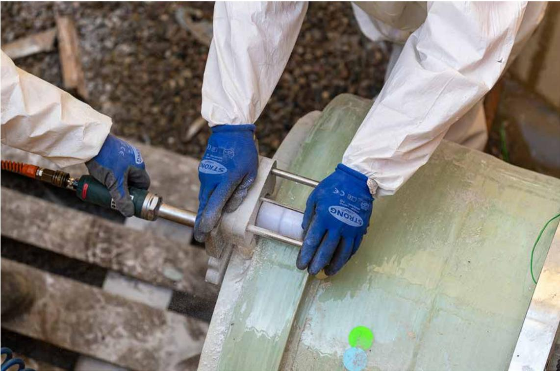
Nacharbeiten am CODURE-Flansch: Rückschnitt des überstehenden Linerendes.
