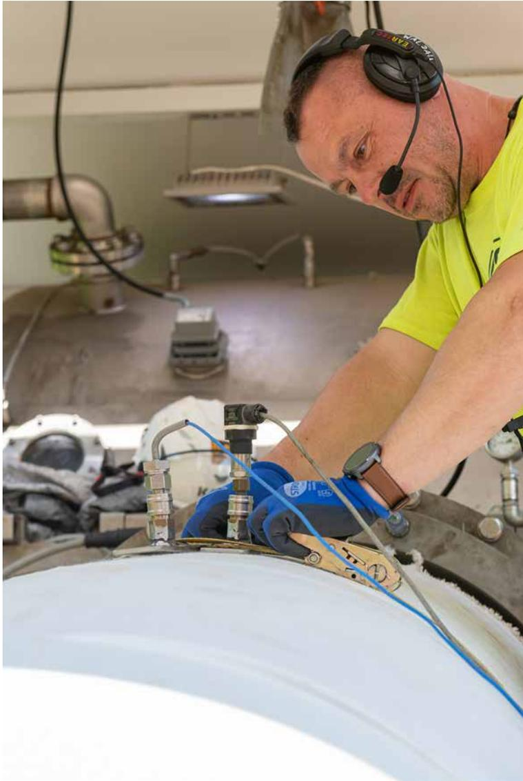
Nach der Installation wird der BlueLiner mit heißem Dampf beaufschlagt und damit der Härtungsprozess in Gang gesetzt.
