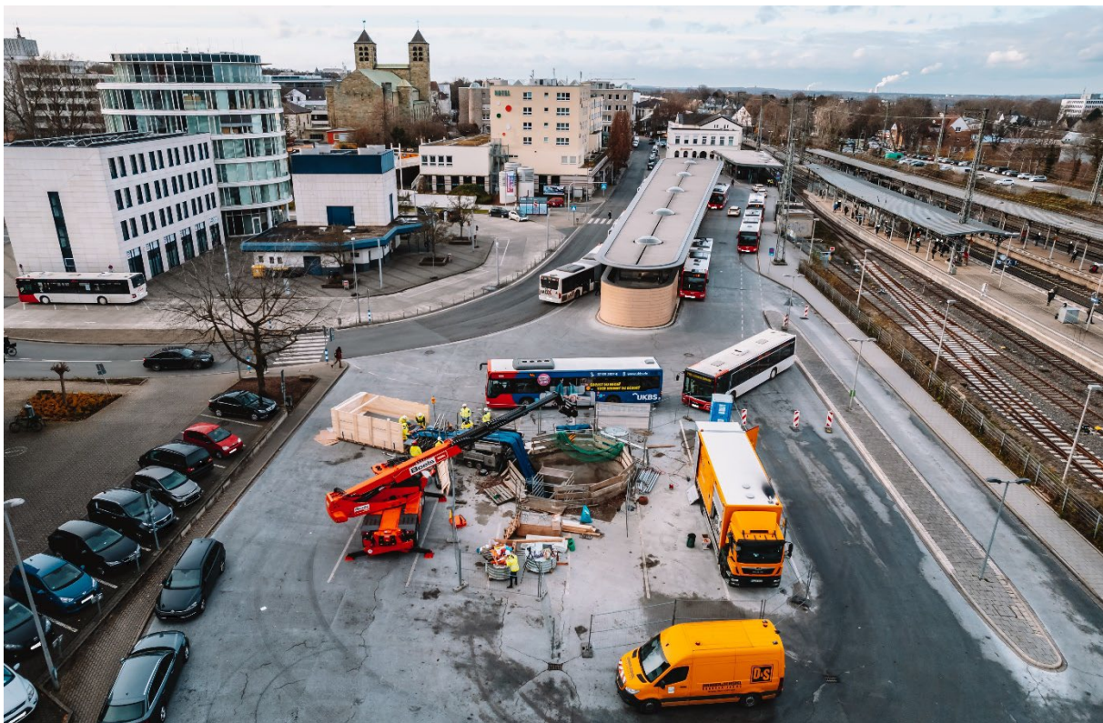
Foto: Sanierungsprojekt Kortelbach an exponierter Stelle: Bahnhof Unna (D&S)
